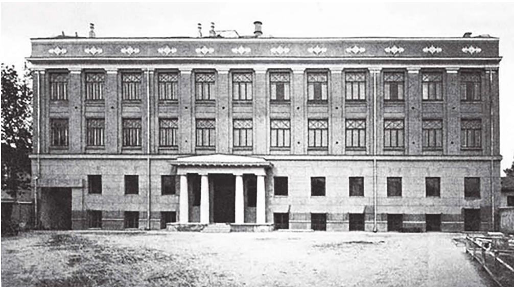
Фото 2.2. Будівля гімназії Аделаїди Жекуліної. Бл. 1912 р.
